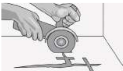
Рис. 3. При крупных трещинах, идущих по всей толщине бесшовного покрытия, необходимо сделать поперечные разрезы при помощи угловой шлифовальной машинки «болгарки». Глубина поперечных разрезов должна составлять до 2/3 от глубины основания. Данные разрезы наносятся на расстоянии приблизительно 25 см друг от друга
